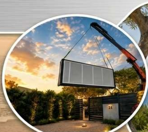
Proceso de Instalación
